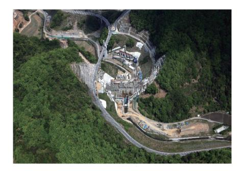
型 式:重力式コンクリートダム 堤 高: 47m 堤 頂 長: 154m
