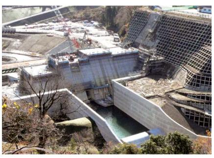
下流より堤体を望む ・減勢工打設完了
