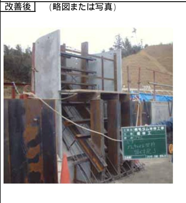
張出し形状にあわせたプレキャストコンクリート型枠を製作。構造物内側よりプレキャスト型枠を吊ることにより支保し、構造物を構築。
